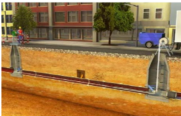
Figure 5 - Mise en place d'un film de protection
