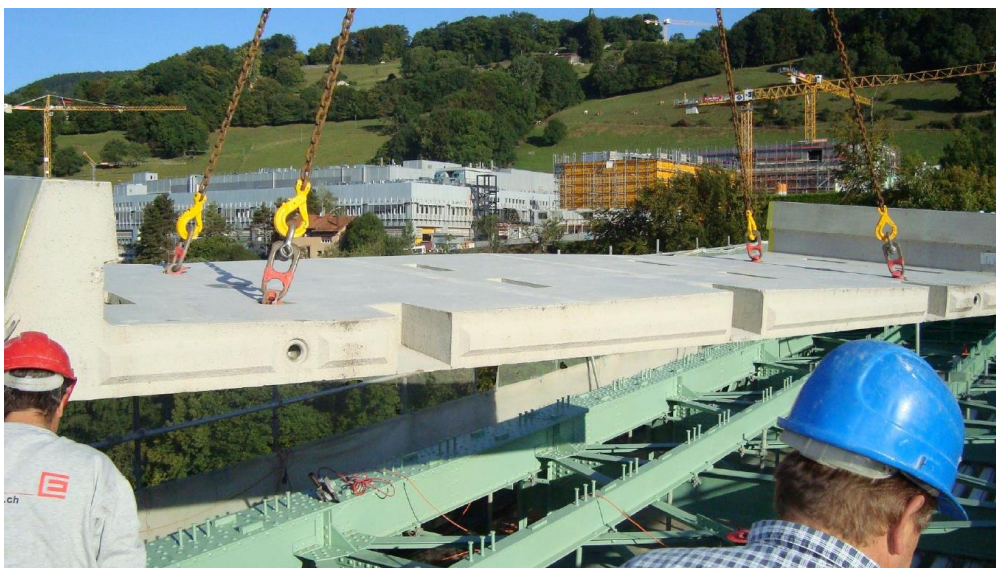
Photographie représentant un élément de dalle similaire à ceux prévus pour ce chantier
