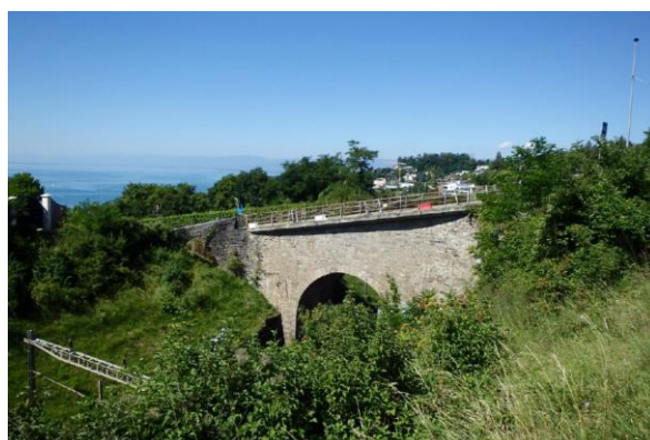
Vue Est du passage supérieur
