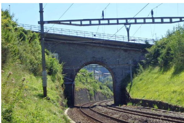
Vue Ouest du passage supérieur
