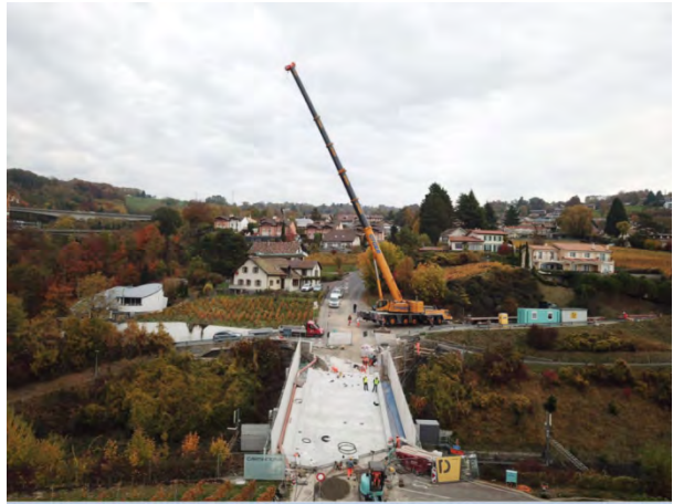
Pose de la nouvelle dalle constituée d'éléments préfabriqués
