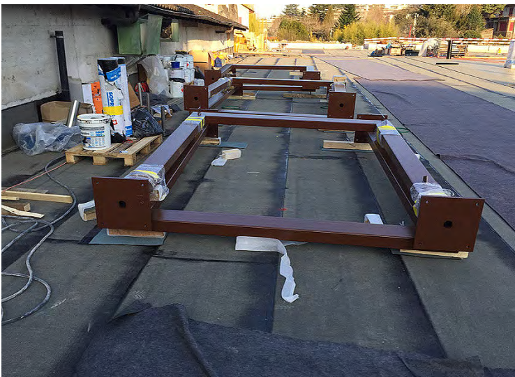
Mise en place de l'abri 2 roues
