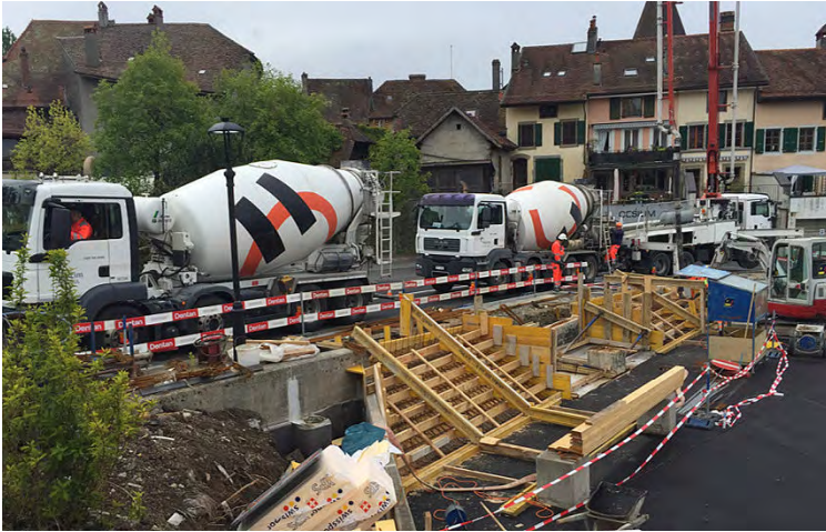
Bétonnage des nouveaux escaliers
