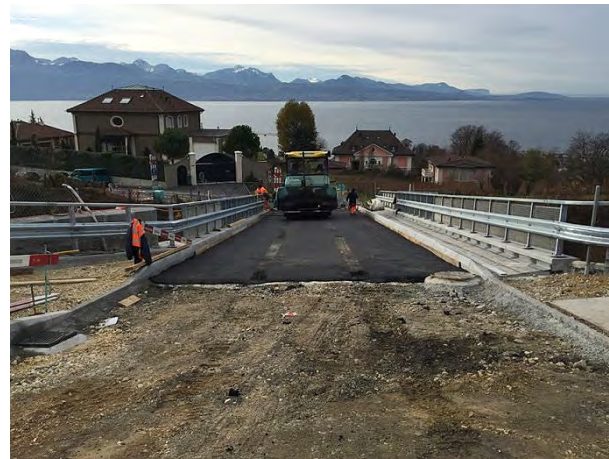
Pose de l'étanchéité et du revêtement
