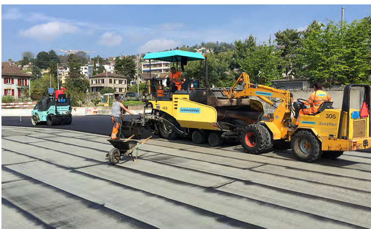
Pose des enrobés
