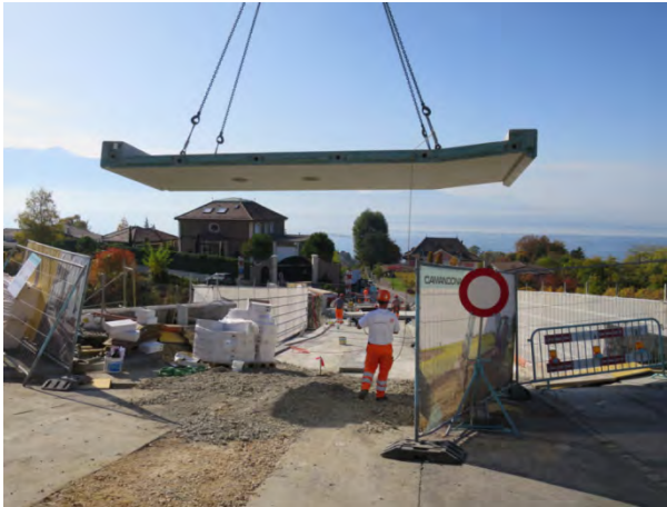
Pose de la nouvelle dalle constituée d'éléments préfabriqués
