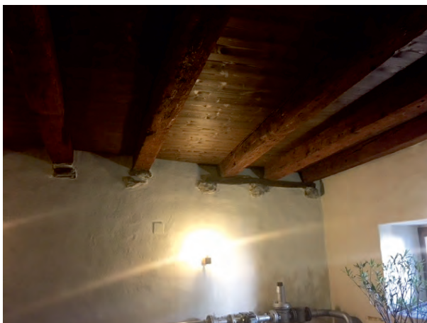
Château des Rôdeurs : nouvelle isolation thermique entre les poutres du hall d'entrée
