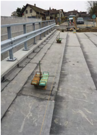
Pose de la nouvelle dalle constituée d'éléments préfabriqués
