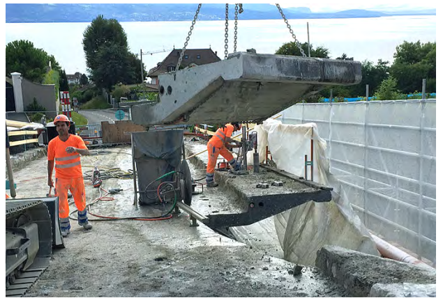
Démolition par sciage de la vieille dalle en béton armé
