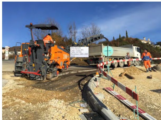
Pose de l'étanchéité et du revêtement
