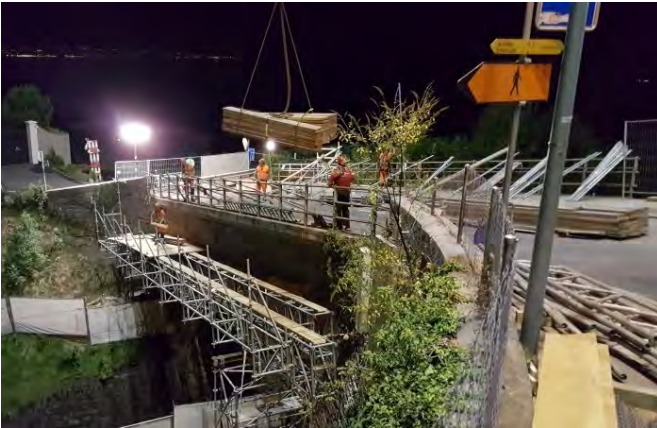
Travaux de nuit pour le montage et le démontage des ponts de travail et de protection au-dessus des voies de chemin de fer.
