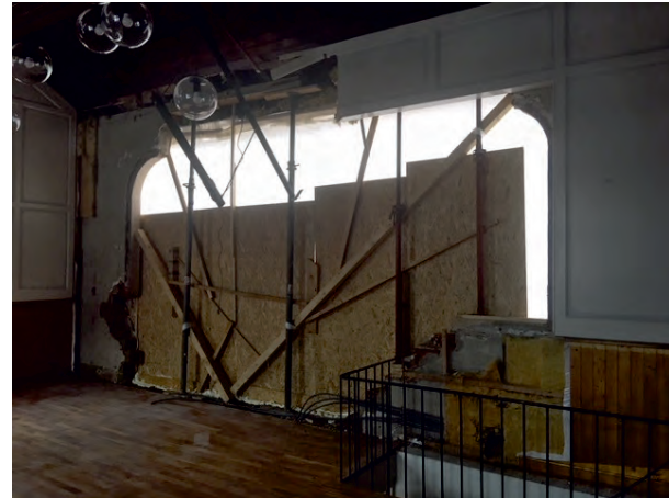
Salle d'Echerins: travaux d'urgence
