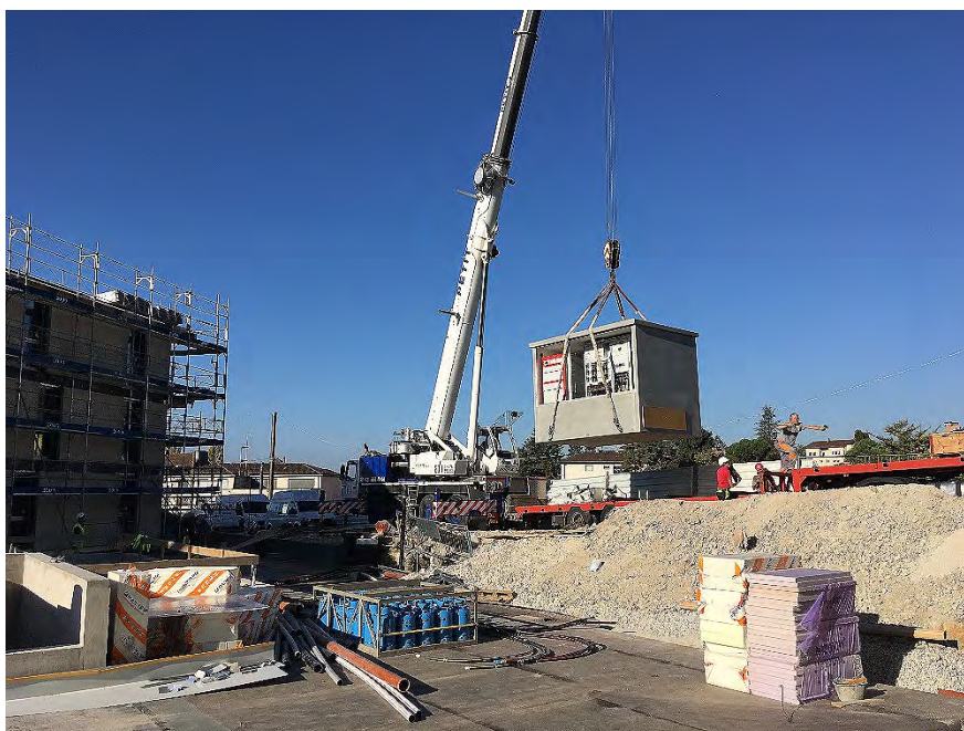
Installation de la sous-station Petite-Corniche octobre 2017
