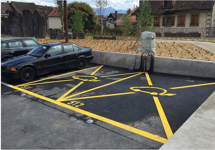
Installation de deux bornes de recharge électrique
