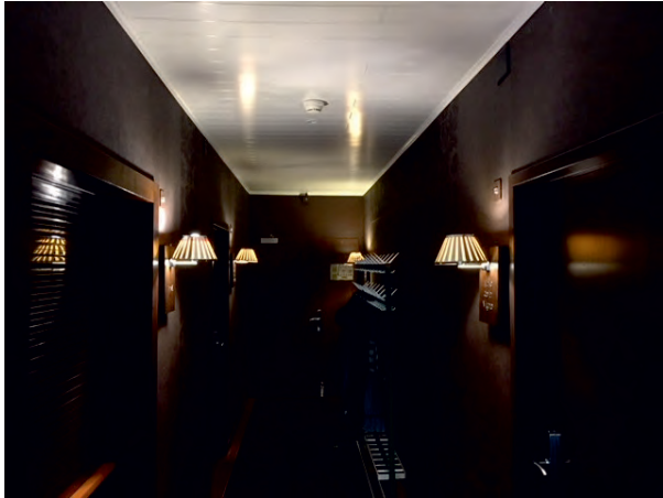
Hôtel "Le Rivage": faux plafond (accès salles de conférence)
