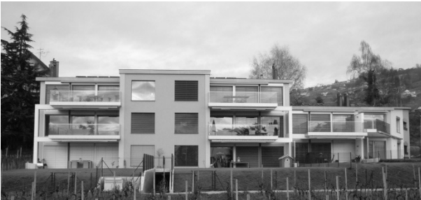
Chemin de Plantaz - Petite Corniche bâtiment résidentiel de 10 logements
