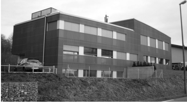
Rte des Mts-de-Lavaux : bâtiment polyvalent (garderie, bureaux, salle de réception)
