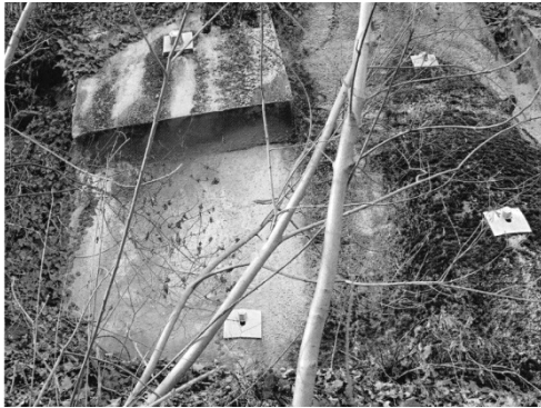
Ouvrage ancré partie Ouest
