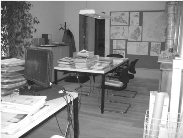
Château de Lutry – Pose d'un parquet dans le bureau du chef de service ATB
