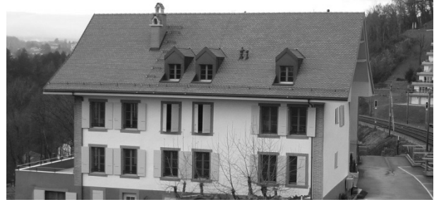
Rte de la Conversion - : transformation d'un bâtiment résidentiel de La Bernadaz 3 logements
