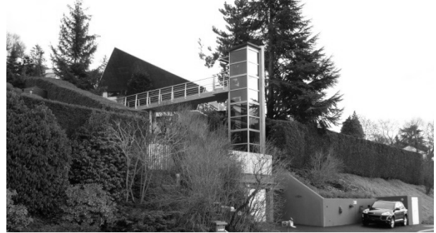
Rte des Mts-de-Lavaux : ascenseur extérieur
