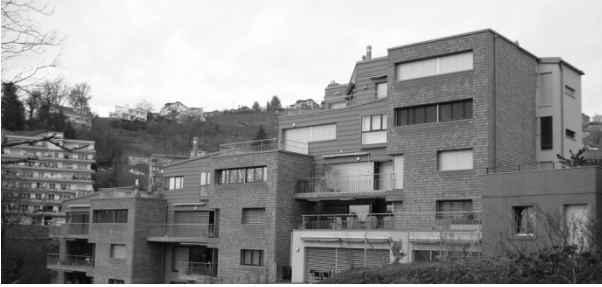
Rte de la Conversion - : bâtiment résidentiel de La Bernadaz 9 logements
