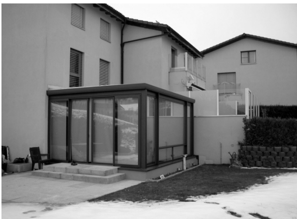
Chemin de la Canélaz : véranda
