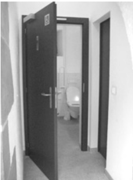
Château de Lutry (cour Nord) – Aménagement d'un WC pour personnes à mobilité réduite
