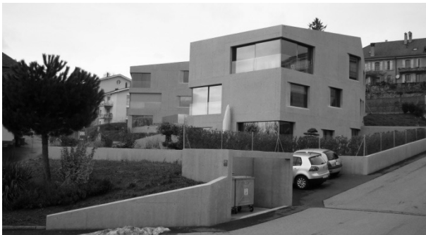
Chemin des Brûlées : bâtiment résidentiel de 2 x 3 logements
