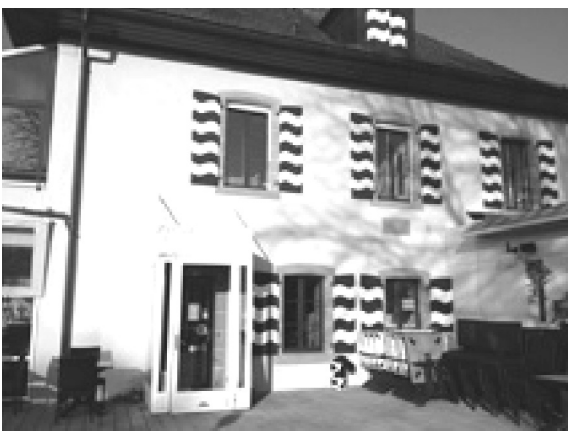
La Lagune – Réfection peinture des volets
