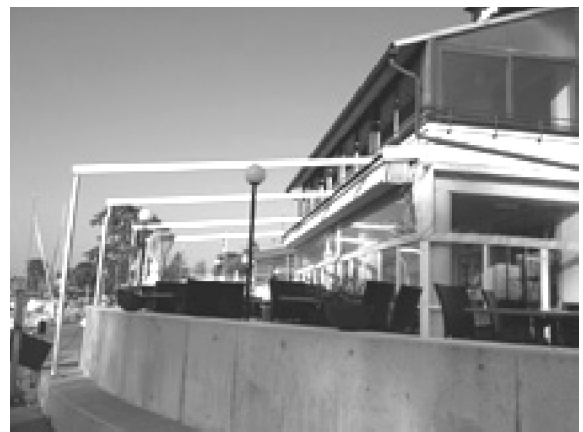
La Lagune – Store sur la terrasse
