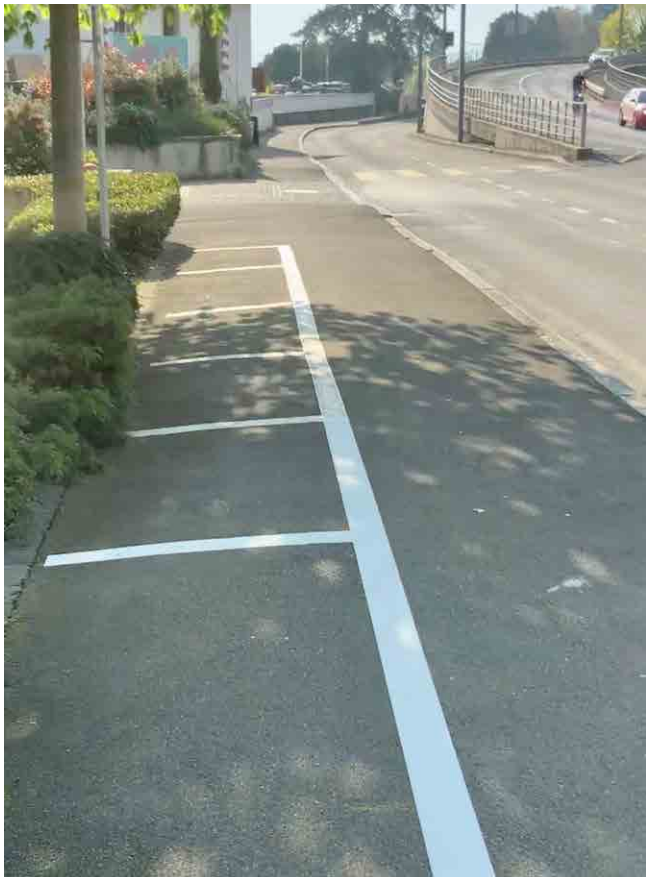
Figure 6 : nouveaux stationnements deux-roues motorisés à la route du Grand-Pont
