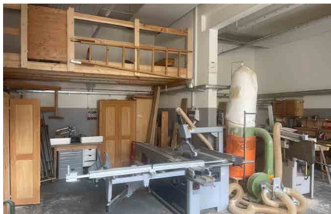
Aménagement d'un atelier pour le menuisier dans les locaux de l'ancien garage (DIMAB)
