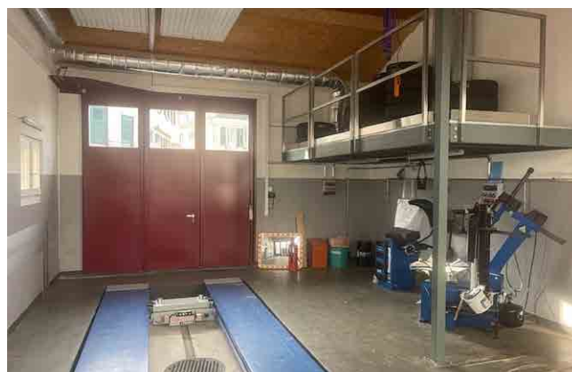
Aménagement d'un atelier pour le mécanicien dans les locaux de l'ancien garage (DIMAB)
