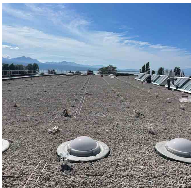
Toiture rénovée de la salle de gym de Corsy avant la pose des panneaux photovoltaïques
