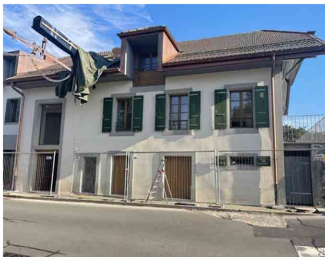
Façade Ouest du bâtiment de "La Balance" après rénovation
