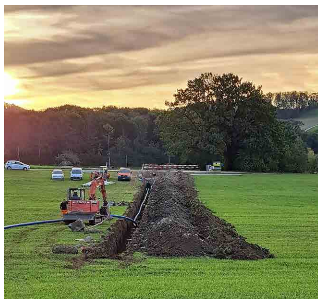
Bois-de-la-Chaux, réalisation d'un nouveau bouclage de réseau.
