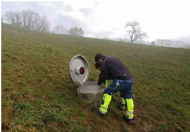
Contrôle et inspection d'une chambre de captage.
