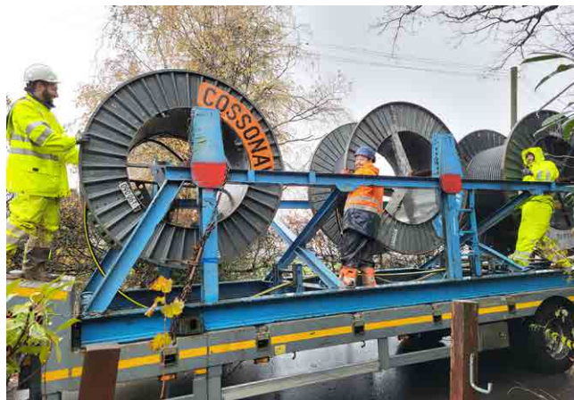
Bois-de-Chaux, utilisation d'une remorque triple bobines.
