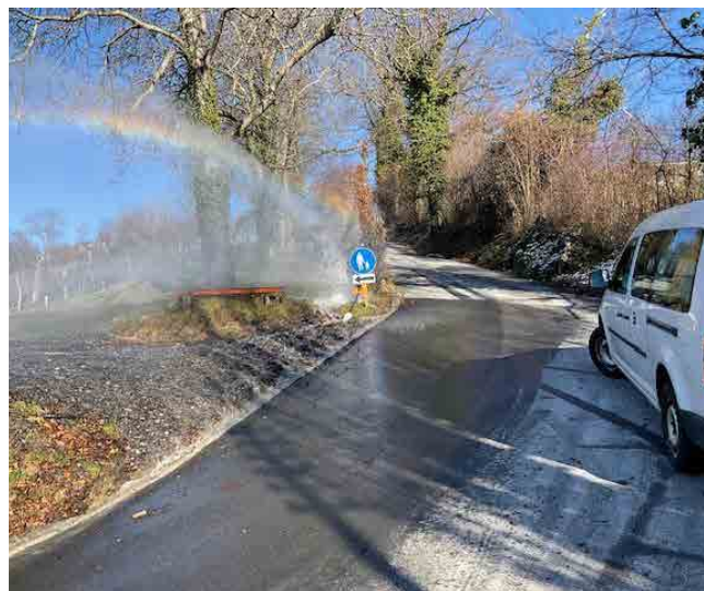
Chemin des Chênes, by-pass d'un chantier privé gelé
