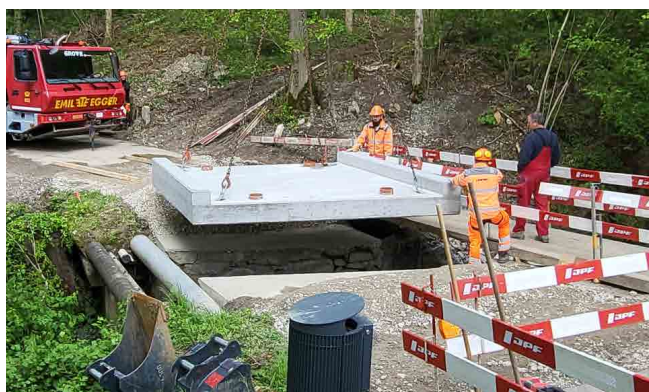
Pont lors de sa pose
