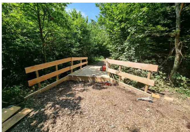
Remplacement de la passerelle
