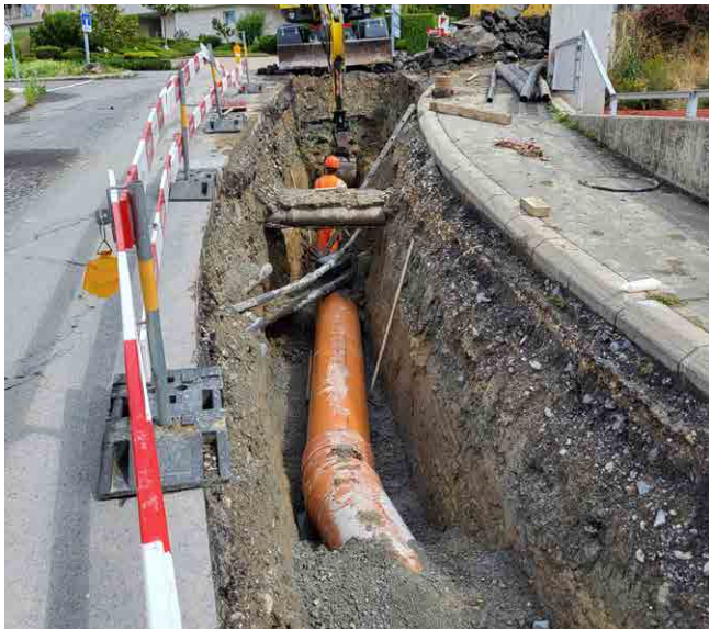
Pose d'un nouveau collecteur
