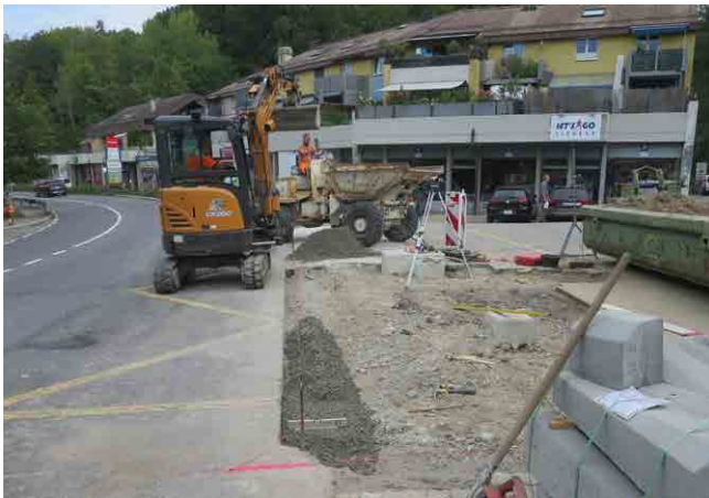
Préparation pour la pose des bordures adaptées LHand
