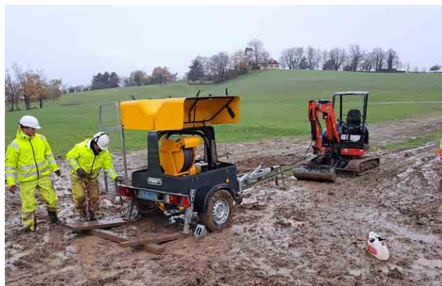
Bois-de-Chaux, tirage d'une importante section de câble basse-tension en 3 x 300 mm 2 .
