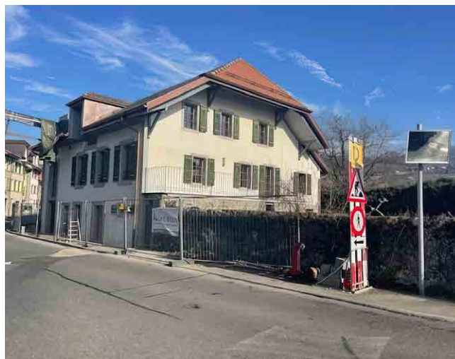
Façade Sud du bâtiment de "La Balance" après rénovation
