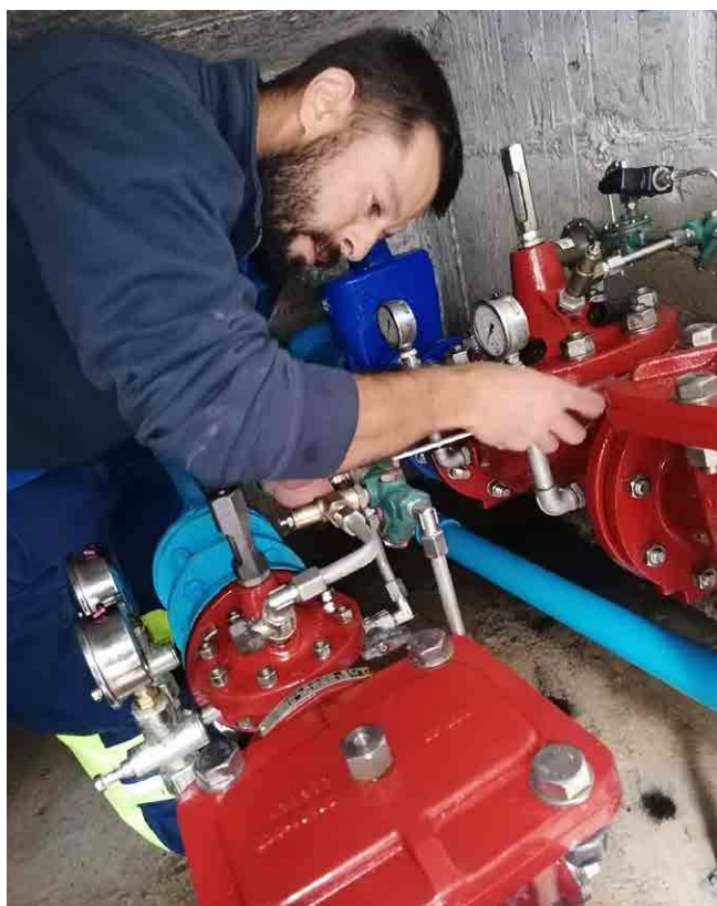
Réglage après révision périodique d'un réducteurs de pression.
