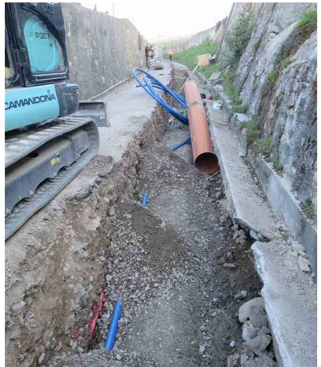
Travaux de fouille
