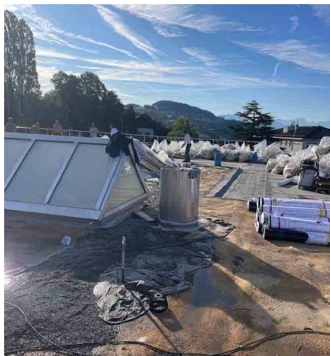
Rénovation du complexe étanchéité-isolation de la toiture de la salle de gym de Corsy
