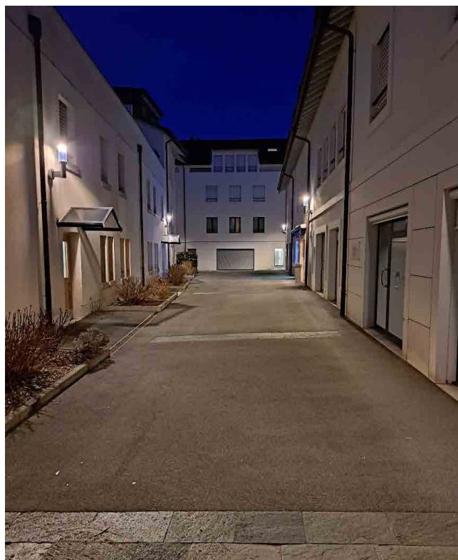
Ruelles des Halles, remplacement d'anciens luminaires avec une technologie LED.
