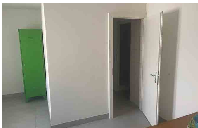
Création d'un vestiaire avec W.-C. et douches pour les dames dans les locaux de la voirie
