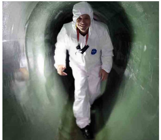
Contrôle d'exécution du chemisage
