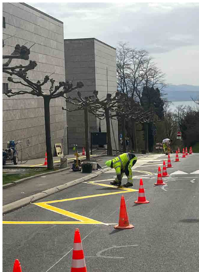
Figure 3 : aménagements de nouveaux marquages aux abords de l'arrêt de transports scolaires Collège de Corsy
