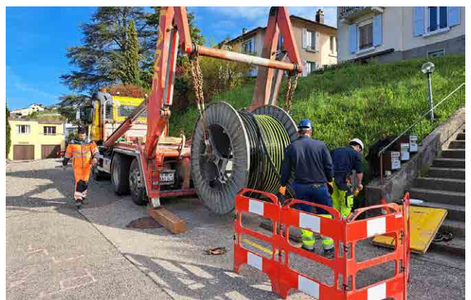
Chantier au chemin des Villas, tirage d'un câble basse-tension.
