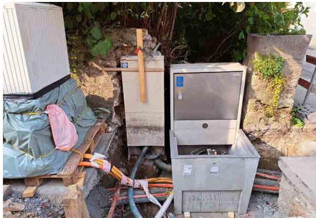
Rte de Vevey, remplacement d'un poste de distribution.
