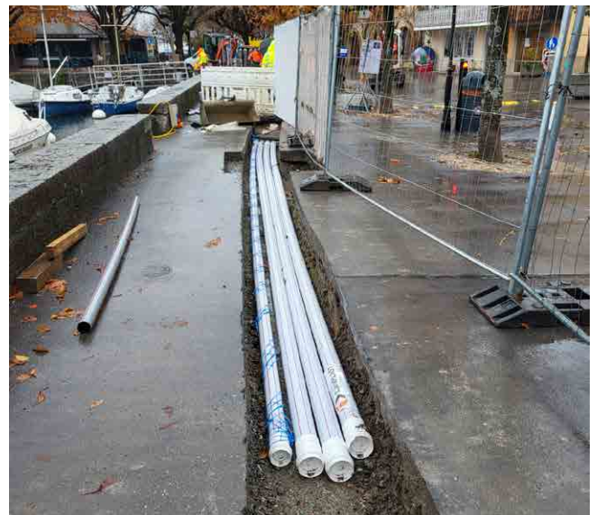
Ce chantier a permis également le remplacement de certaines conduites électriques
