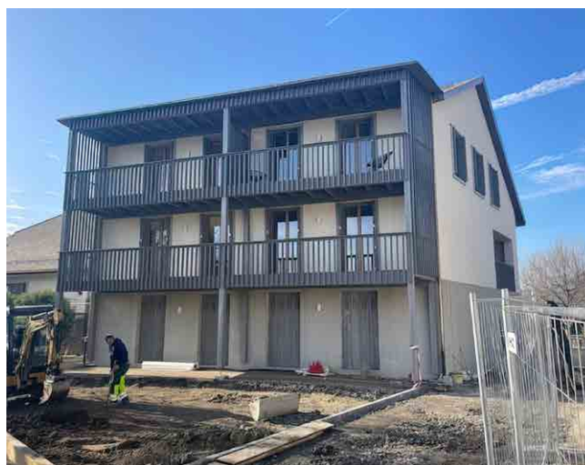
Façade Est de l'agrandissement de "La Balance"
