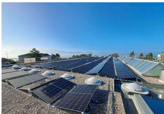
Collège de Corsy, réalisation d'une installation photovoltaïque.
