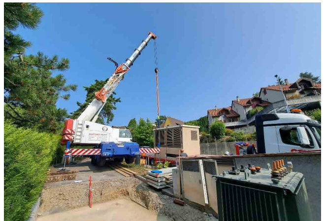
Station Collonges, livraison du nouveau bâti ainsi que des équipements électriques.
