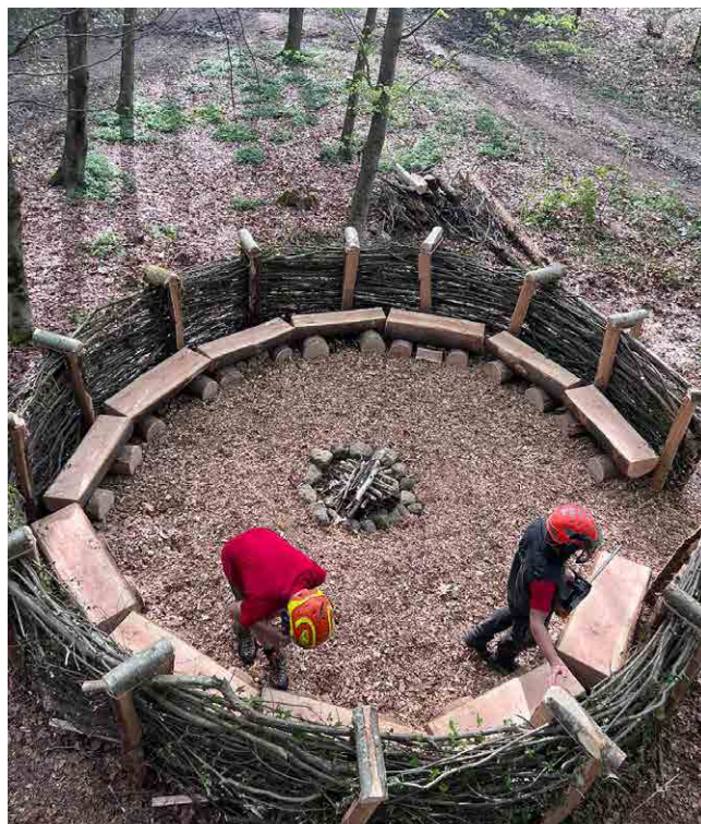
Construction du canapé forestier
