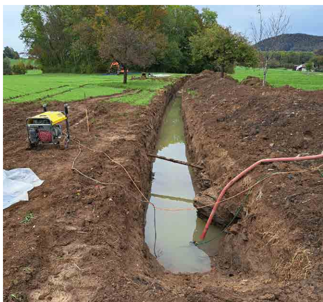
Bois-de-Chaux, réalisation de fouilles avec une météo capricieuse.
