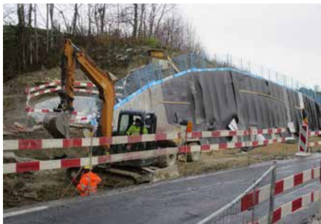
Travaux de soutènement en cours
