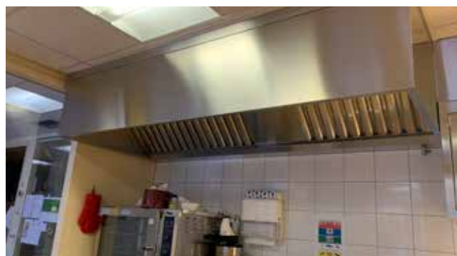
Mise en œuvre d'une nouvelle hotte de ventilation dans la cuisine de la garderie des Moulins.
