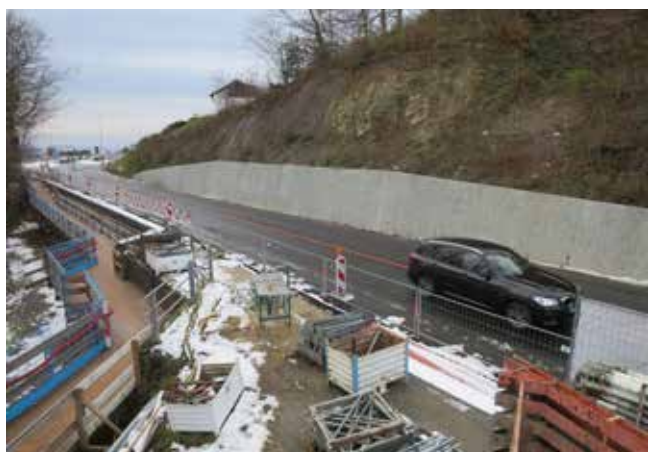
Travaux de soutènement terminés
