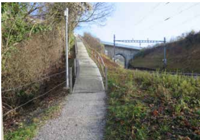
Sentier de la Ligne CFF - Secteur Brélaz assaini
