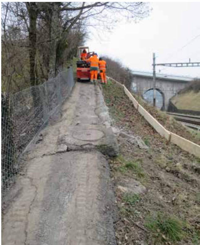
Sentier de la Ligne CFF - Secteur Brélaz – en chantier
