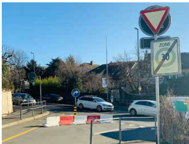
Figure 7 : aménagement d'une interdiction de tourner à gauche depuis le chemin de Burquenet sur la route de La Conversion.
