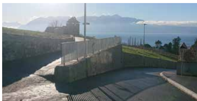
Mur de soutien au chemin de Bertholod
