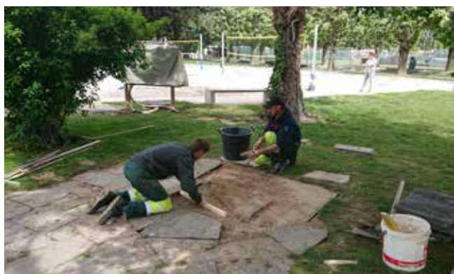
Aménagement d'un dallage pour la pose du cabanon
