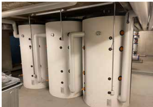
Mise en œuvre d'un accumulateur de chaleur dans la chaufferie du centre scolaire de Corsy
