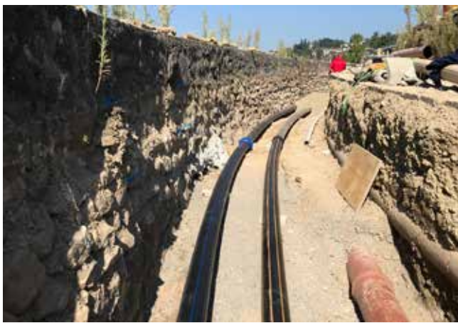
Chemin de Bertholod, remplacement conduite électrique, extension conduite de gaz
