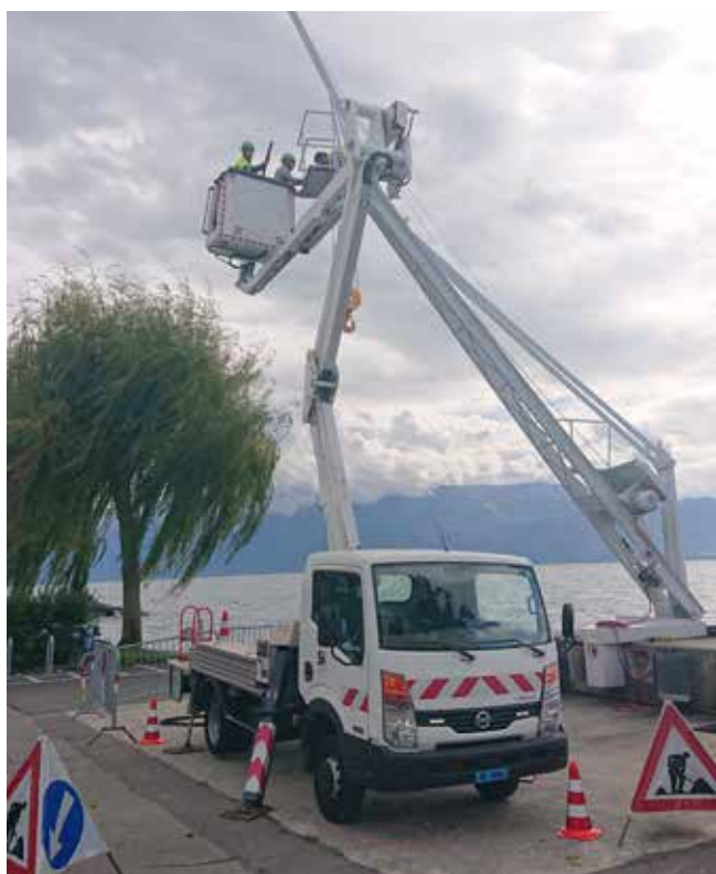
Fixation de protection en caoutchouc sur la grue à bateau
