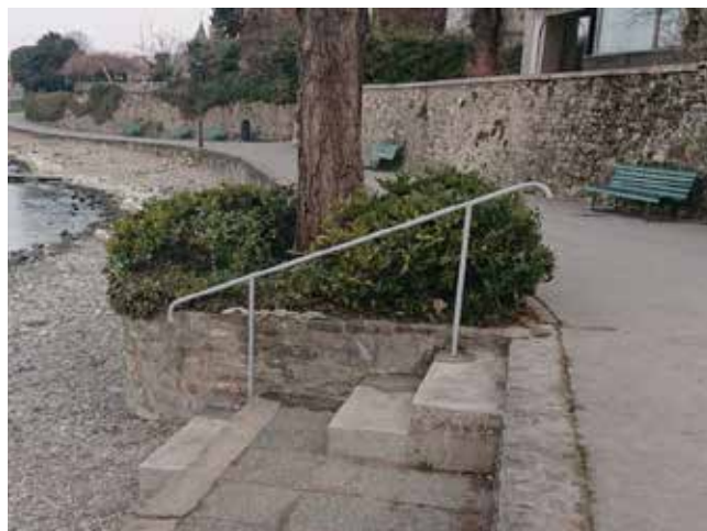
Fabrication d'une main-courante pour la plage
