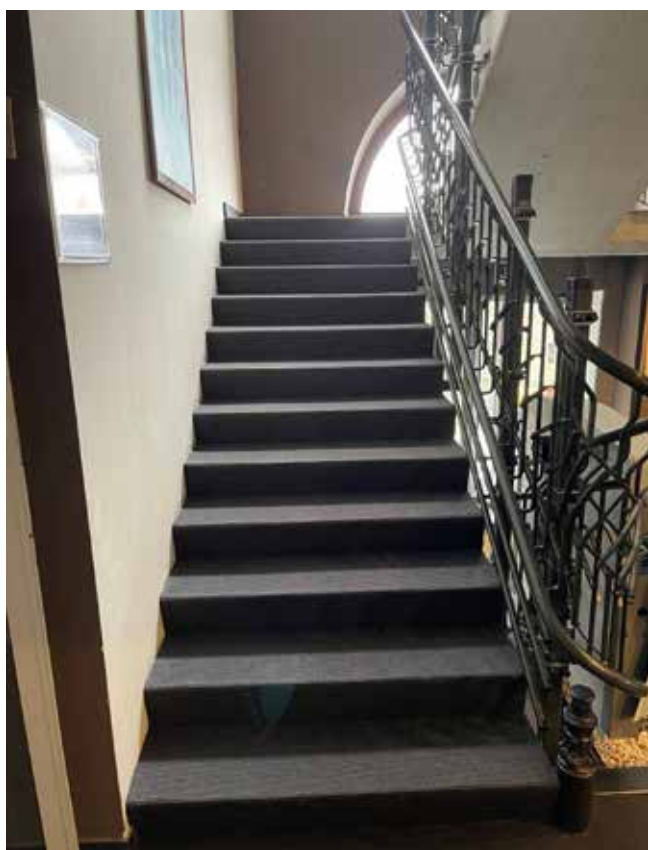
Remplacement de la moquette dans la cage d'escaliers principale de l'Hôtel du Rivage.
