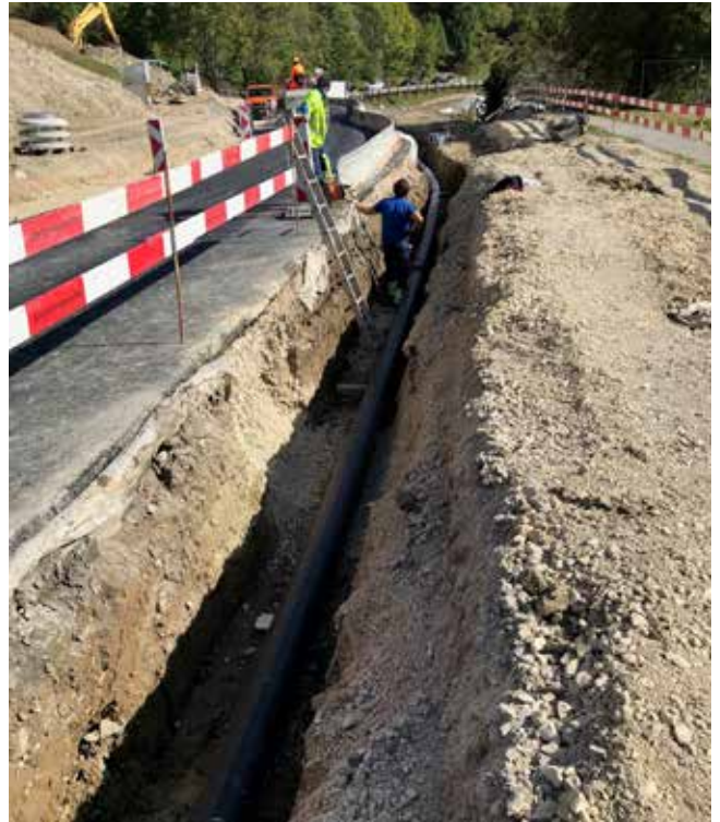
Route des Monts-de-Lavaux, pose d'une nouvelle conduite d'eau (remplacement)
