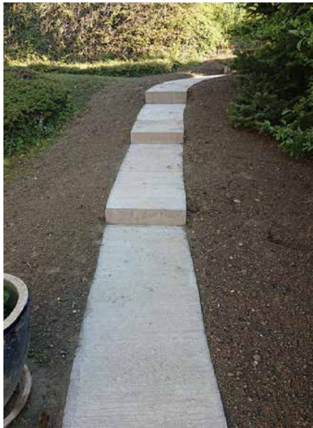
Construction d'un cheminement piétonnier au ch. du Mâcheret
