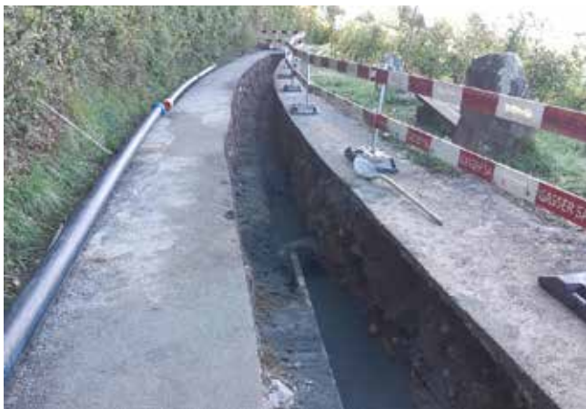
Chemin du Daley, pose d'une nouvelle conduite d'eau pour l'alimentation du hameau du Daley
