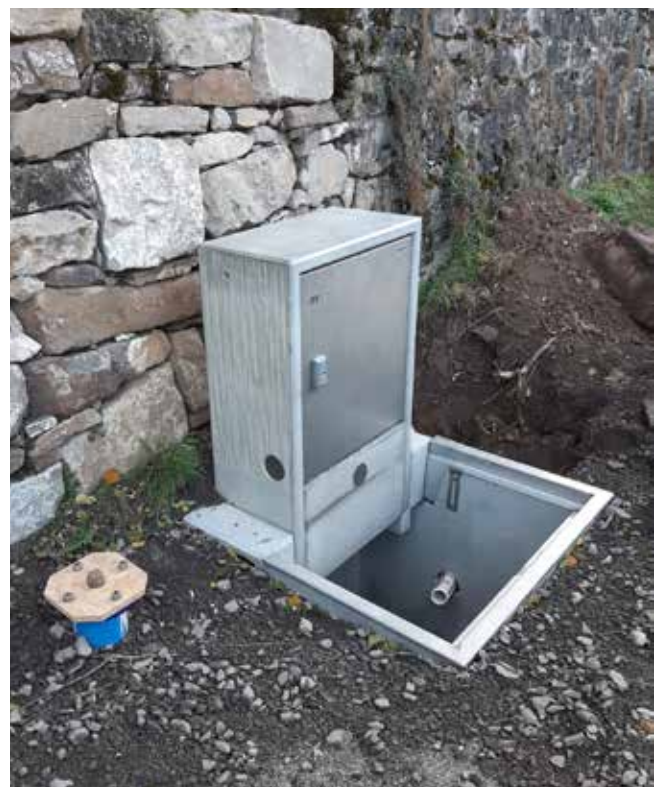
Daley, pose d'un nouveau poste de distribution (PD)
