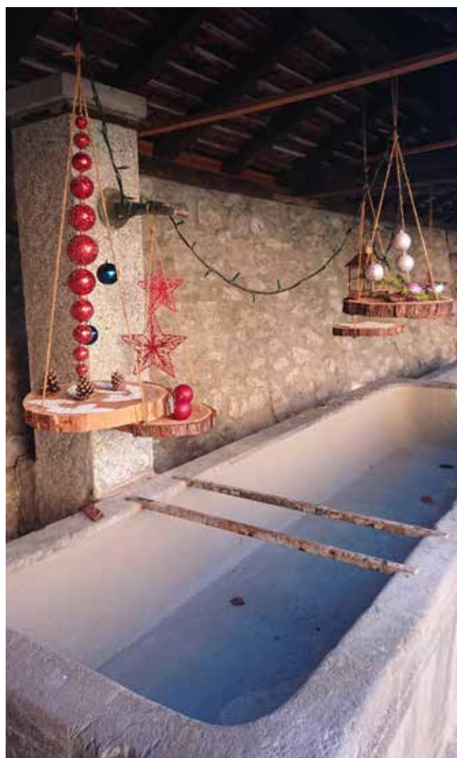
Fontaine de Corsy-Dessous après les travaux d'étanchéité
