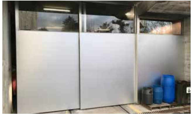
Nouvelle porte coulissante
