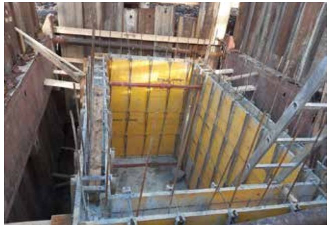
Chemin des Chênes, construction d'une chambre pour réducteur de pression
