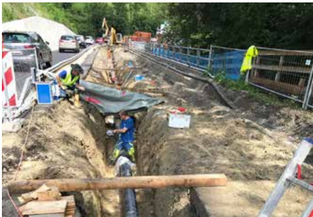
Route des Monts-de-Lavaux, pose conduite d'eau
