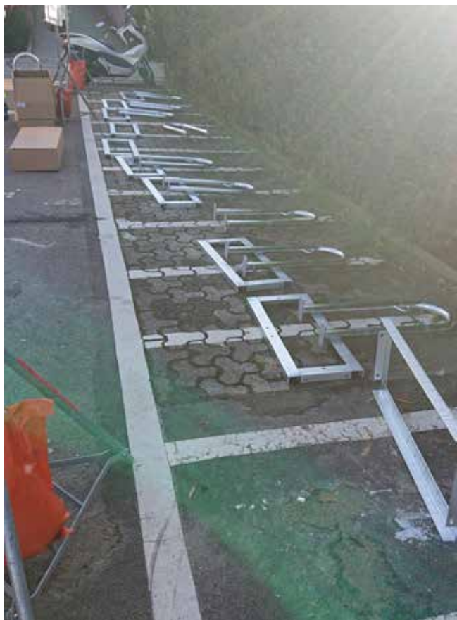
Pose de support à vélo
