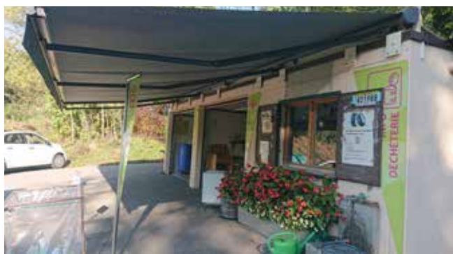
Installation d'une protection solaire devant les locaux de la déchèterie.
