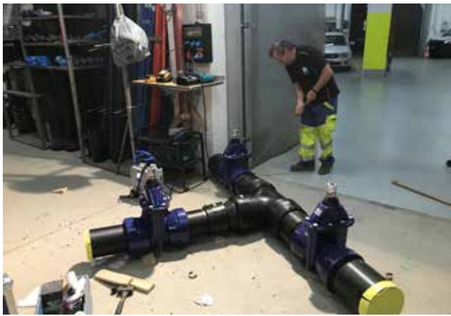
Route des Monts-de-Lavaux, préparation d'un jeu de vannes
