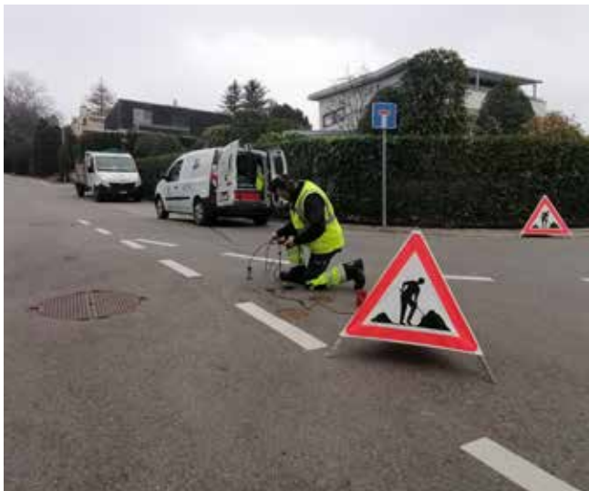
Recherche et localisation de fuite par corrélation
