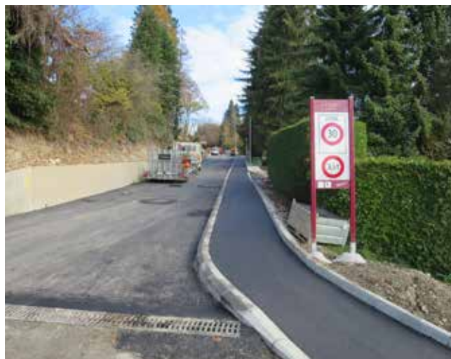
Nouveau trottoir au chemin de Crêt-Ministre
