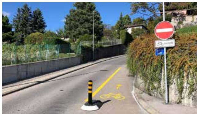
Figure 2 : aménagement pour sécuriser le contresens cyclable de la route de Crochet.
