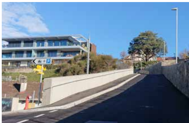
Trottoir sur le tunnel Bertholod
