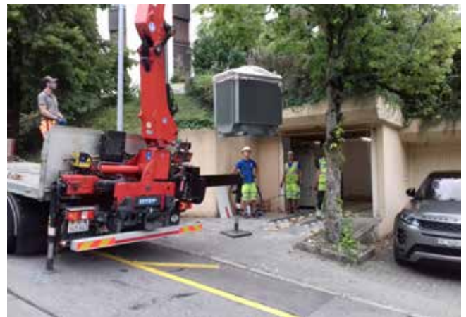
Route de la Conversion (APAL), remplacement du transformateur de la sous-station Duboule
