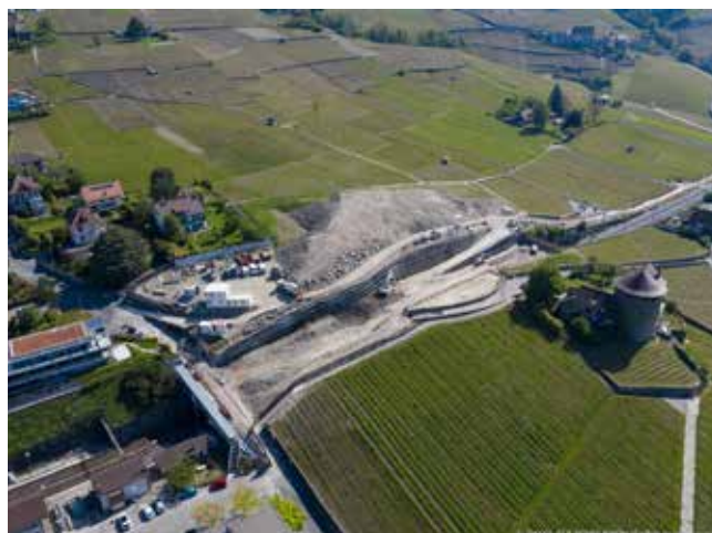
Vue aérienne du chantier CFF
