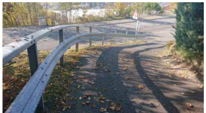
Remplacement de la glissière de sécurité au ch. de la Sapelle
