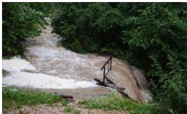
Lutrive en crue avec la herse existante complètement noyée
