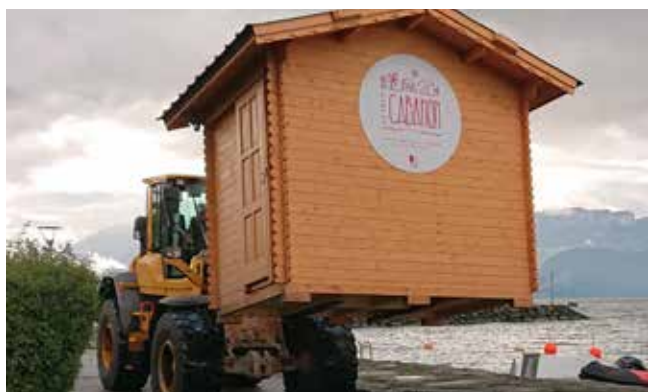
Mise en place du Cabanon
