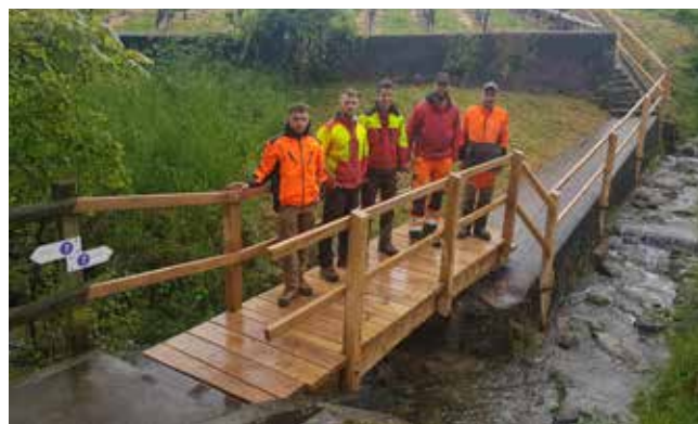
Passerelle du sentier du Châtelard
