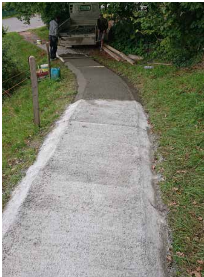
Construction d'un cheminement piétonnier au Collège de La Croix
