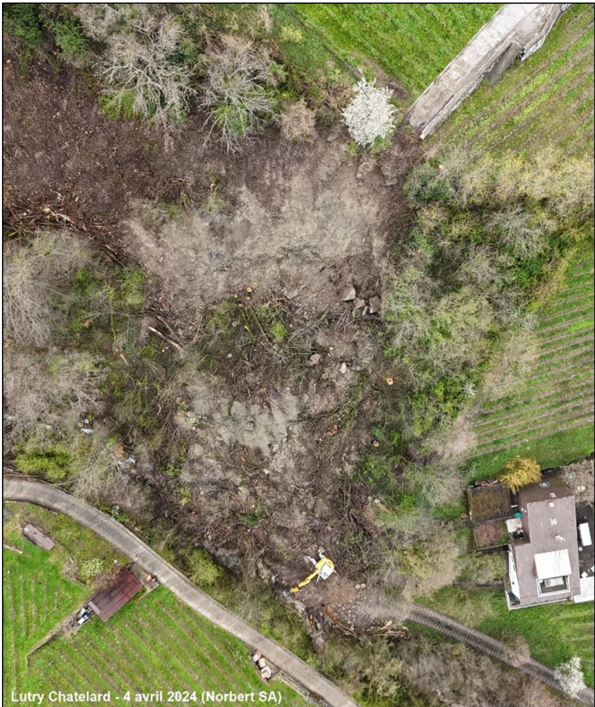
Figure 3 : Prise de vue du glissement de terrain du Châtelard
